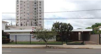
26 - AV. LEOPOLDINO DE OLIVEIRA, N°3205 - BAIRRO ABADIA
