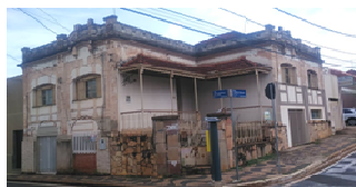
37- R. CARLOS RODRIGUES DA CUNHA, Nº148 ESQ. R. CAPITÃO MANOEL PRATA
