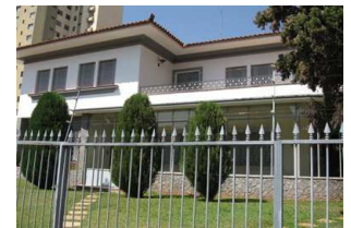
27- AV. LEOPOLDINO DE OLIVEIRA, N°3239 - BAIRRO ABADIA
