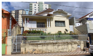
39- CONJUNTO R. SANTO ANT NIO ESQ. R. OLEG RIO MACIEL, N 28 - BAIRRO CENTRO
