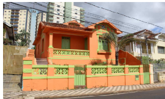
40- CONJUNTO R. SANTO ANTÔNIO ESQ. R. OLEGÁRIO MACIEL, N° 42 - BAIRRO CENTRO
